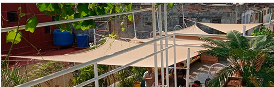
Fig. 12. Área cubierta con mantas, fuente: elaboración propia.
