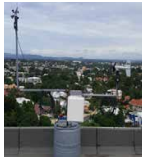
Fig. 4. Anemómetros de veletas Young instalados en INTEC. Elaboración Propia.
