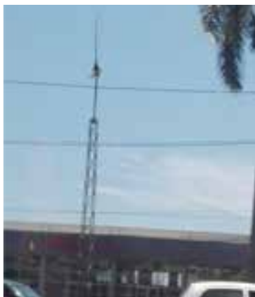
a) Restos de turbina eólica horizontal.
