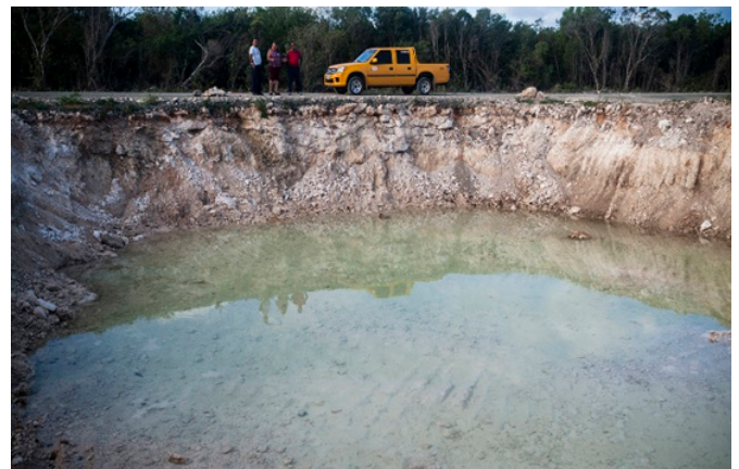
Ilustración 3. Construcción de la base de un Aerogenerador (Fuente: Cubahora).
