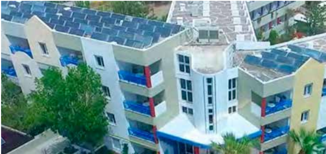
Fig. 4. Hotel Ibsicos Garden Blue Star, Grecia. Hotel de ciudad con 324 camas que cubre 50 % de su energía mediante FRE (solar fotovoltaica y térmica).
