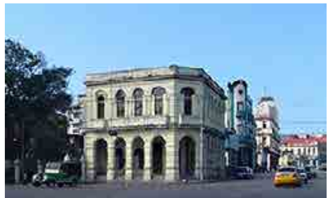
Fig. 5. Vista del edificio de la Quinta de los Molinos.
